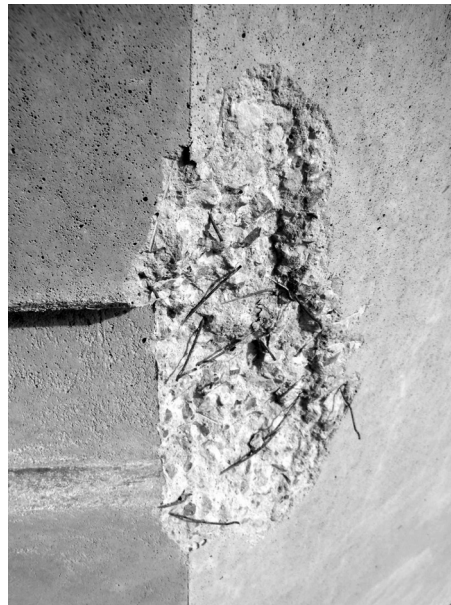
4. ábra. Acél szálerősítésű beton sérülés utáni rozsdásodása (a szerző felvétele)
